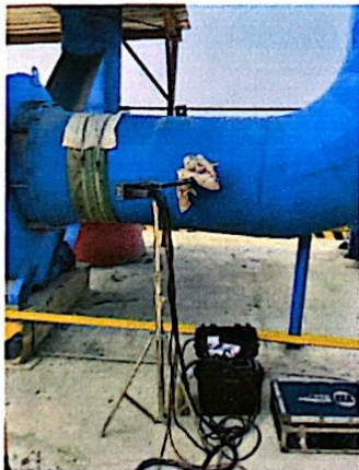
矿山破碎排气筒出口
