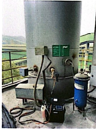
一号煤磨排气筒出口
