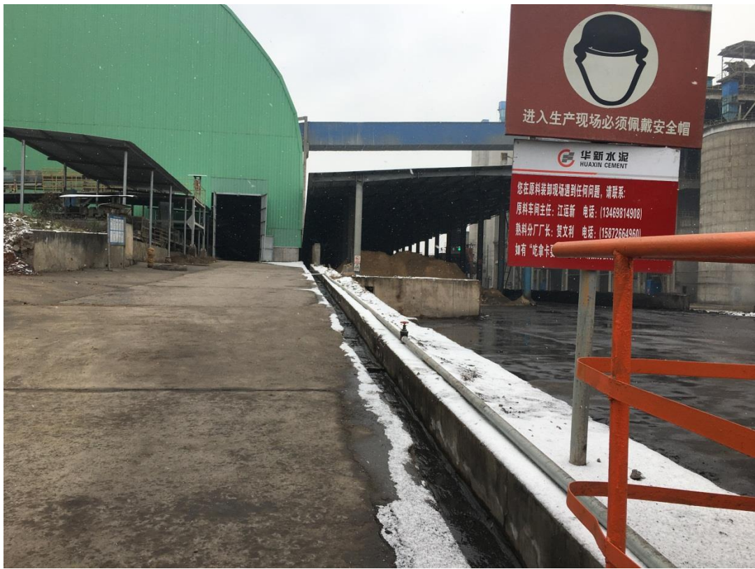
雨水收集管网
